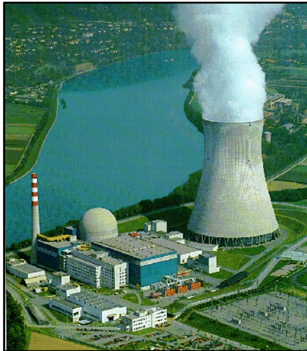
Figura 2.4 Torre de Enfriamiento
