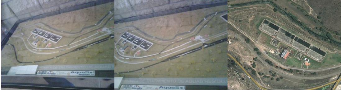
ILUSTRACIÓN 2.6.3 PLANTA TRATADORA DE AGUAS RESIDUALES, MORELIA
