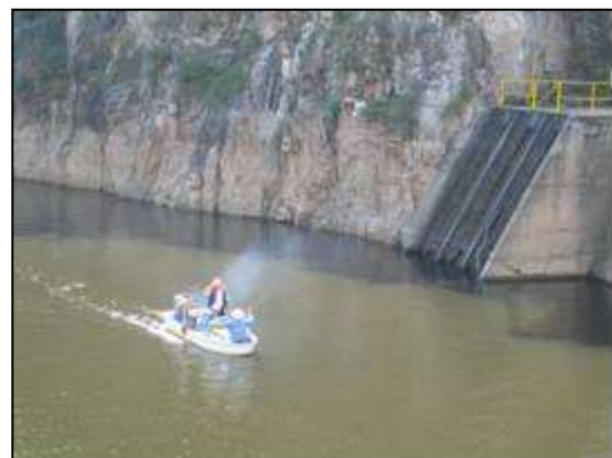
Figura 1-7 Trabajos realizados en el embalse
