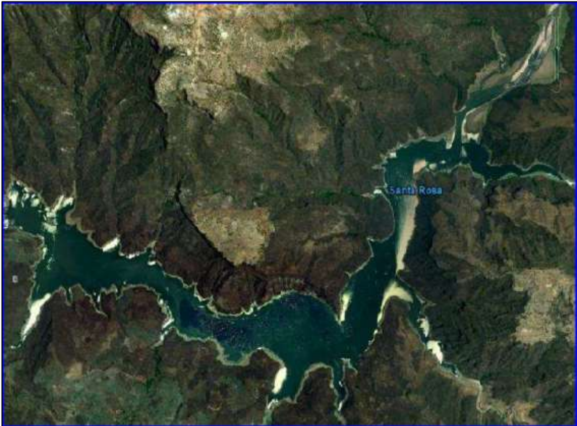
Figura 3-4 Vista en Google de la zona de estudio de la presa Sta. Rosa
