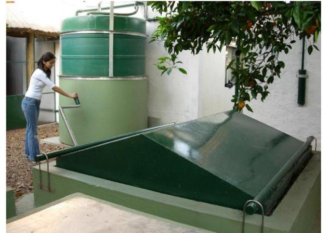
Fig. 57. Biodigestor en funcionamiento con aprovechamiento de biogás.
