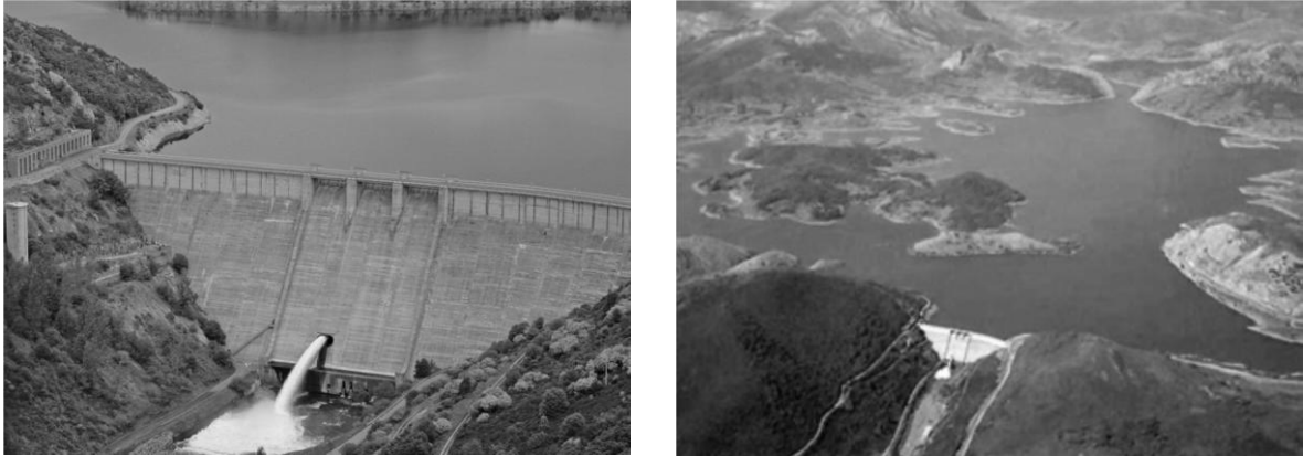
Figura 3. 9 Presa de Gravedad, Porma España. ( www.chduero.es )
