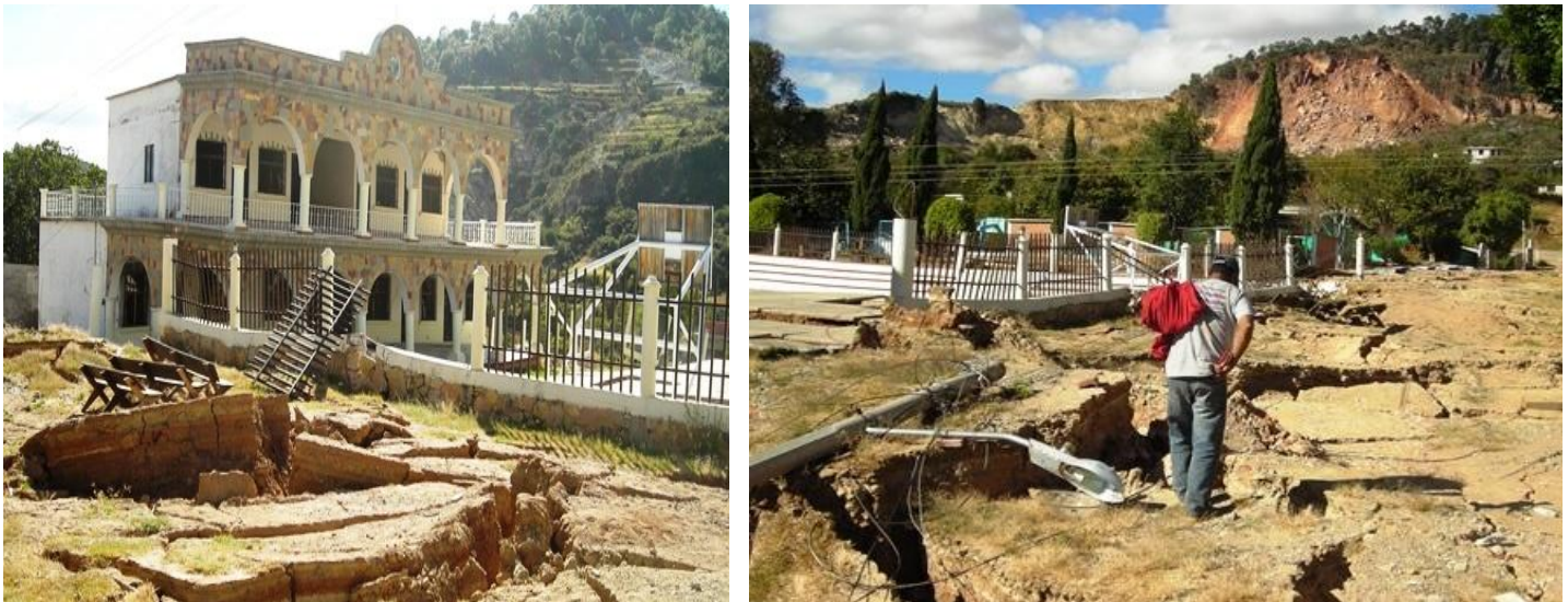
Figura 5. 6 Daños ocasionados por una falla geológica en el Municipio de Asunción Nochixtlán, Oaxaca. ( Http://mexico.cnn.com , 2011)
