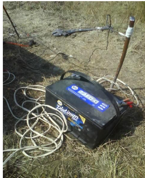
Figura 4. 24 Detalle de la conexión de los cables de las estacas a la batería.
