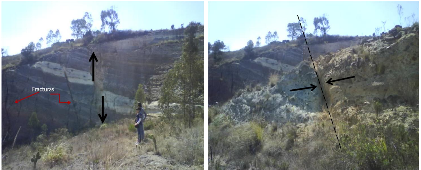
Figura 5. 10 Falla principal y Reflejo de la falla en el talud ubicado al frente de la falla principal. 2012
