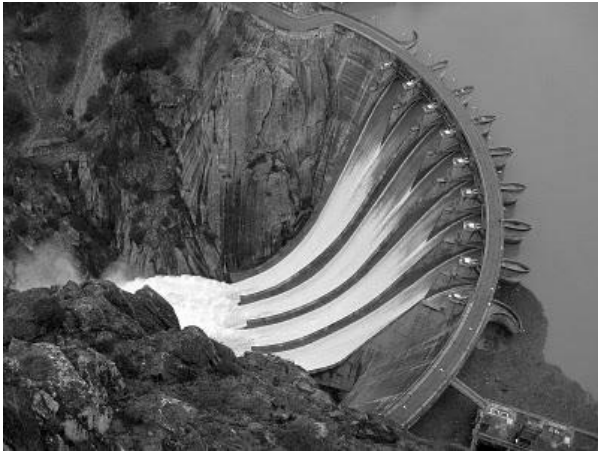
Figura 3. 11 Presa de Arco-Gravedad Aldeadávila. ( http://ingenieriycomputacion.blogspot.com/2010 ).
