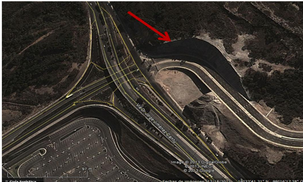
Figura 5. 11 Imagen donde se muestra claramente la excavación del cerro donde se observaba la prolongación de la falla, así como el concreto lanzado que fue colocado para ocultar la falla. (Google Earth, 2013).
