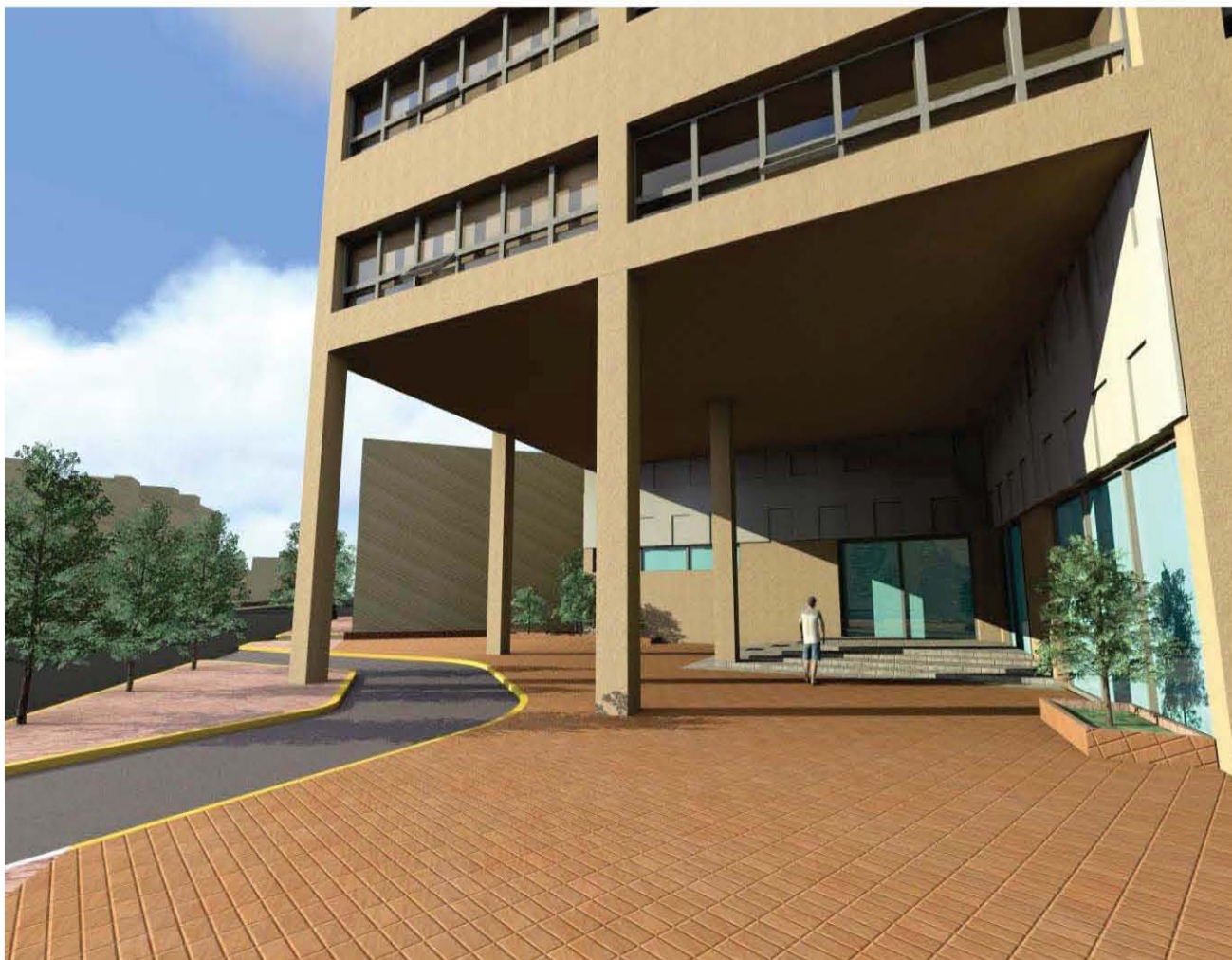
Vista de la bahía vehicular y del pórtico de acceso de la Torre de Oficinas sobre Avenida Insurgentes.
