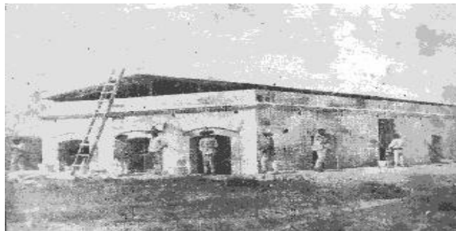
Estación Sismológica de Oaxaca, Oax.
