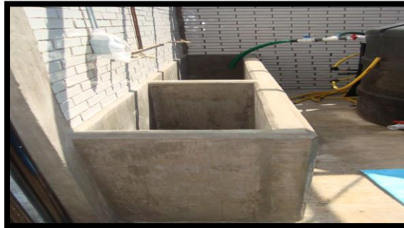
Figura 4. 8 Espesadores de lodos
