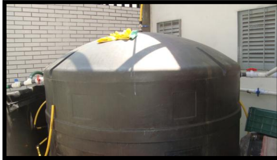
Figura 4. 7 Digestor de 5000 L
