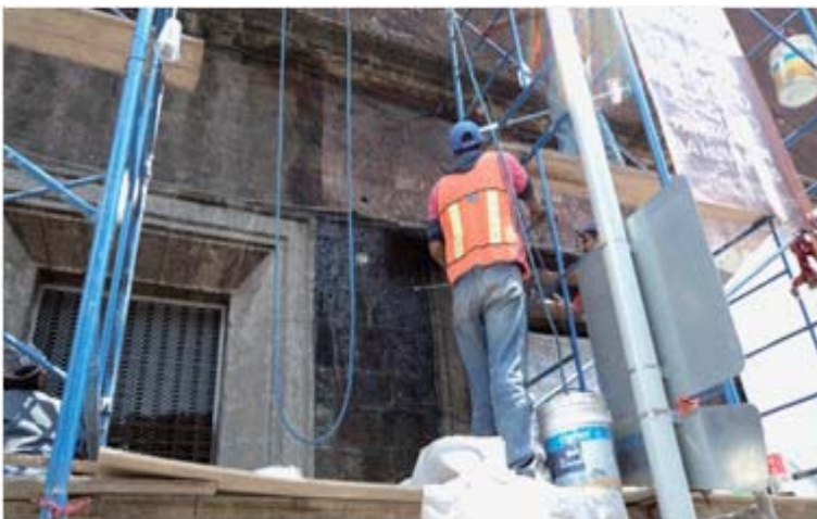
8. Limpieza de tezontle con agua a presión
