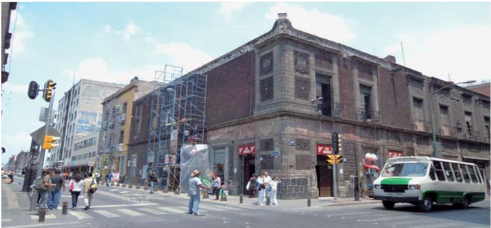
9. Trabajos de mejoramiento imagen urbana
