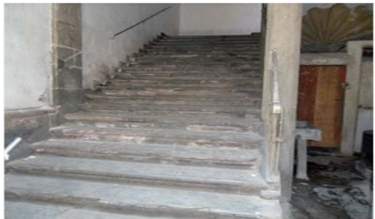
17. Escaleras estado actual
