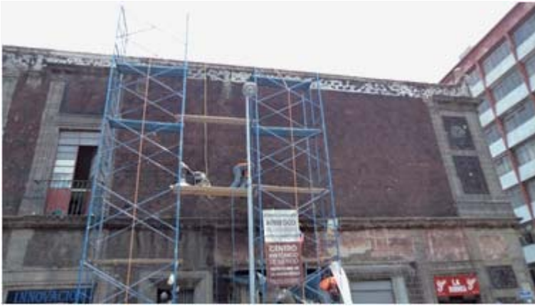
7. Trabajos de limpieza en fachada
