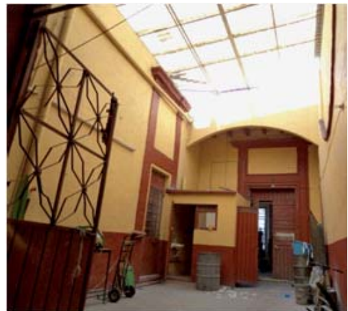
13. Interior Planta alta
