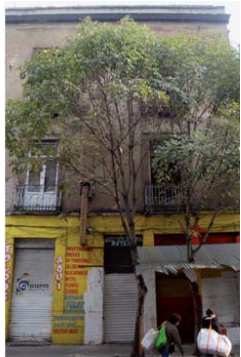
25. Fachada del edificio a demoler
