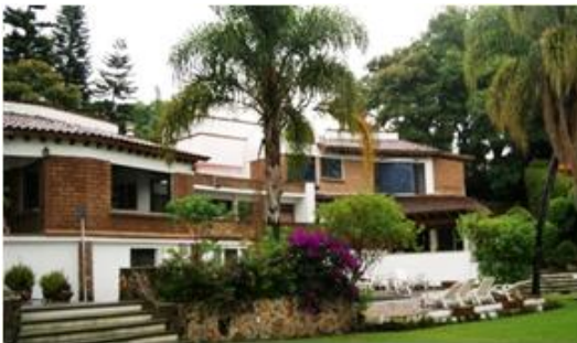
Fachada principal del conjunto.
