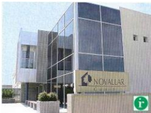
Fachada principal del conjunto.
