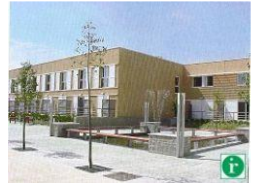
Construcciones amplias, cómodas, luminosas, sin barreras arquitectónicas..
