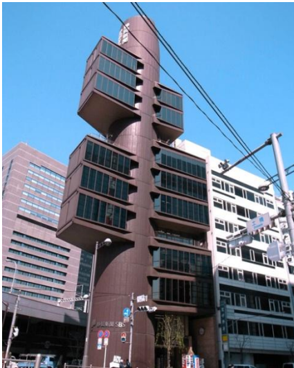
Shizuoka Press and Broadcasting Center, Japón. Arquitecto Kenzo Tange.
