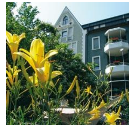
Fachada principal del conjunto.
