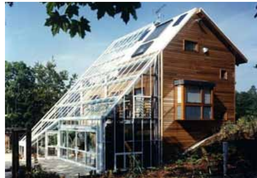
Img. 34. Integer Millennium House , una de las primeras casas en integrar calefacción, agua caliente y producción de energía eléctrica con la ayuda de tecnologías de captación de energía solar. Cole Thompson, 2000.
