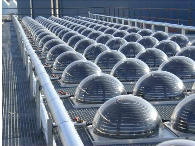
Figura. 2.7.- Colector solares semiesféricos
