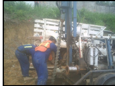
FOTOGRAFÍAS No. 4 Y No. 4-A. Exploración del sitio, mediante la utilización de barrenas helicoidales solidas con equipo mobil dril B-24.
