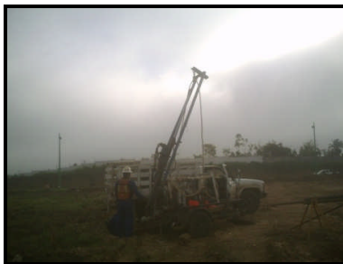
FOTOGRAFÍAS No. 3 Maniobras de acomodo del equipo para dar inicio con la exploración.
