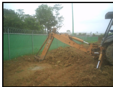
FOTOGRAFÍAS No. 8 Y No. 8-A Elaboración de sondeos tipo pozo a cielo abierto (PCA), con retroexcavadora de contratación local.
