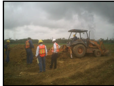
FOTOGRAFÍAS No. 7 Y No 7-A Recuperación de muestras contenidas en el muestreador de media caña (tubo partido).
