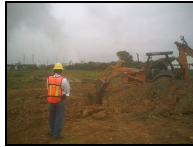
FOTOGRAFÍAS No. 10 Y No 10-A Relleno de la oquedad resultante de los sondeos tipo pozo a cielo abierto, de acuerdo con las políticas de seguridad del cliente y el laboratorio.
