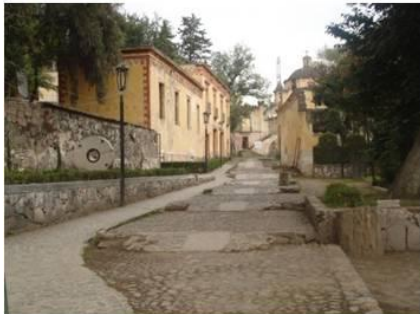
G 15. CALZADA PRINCIPAL
