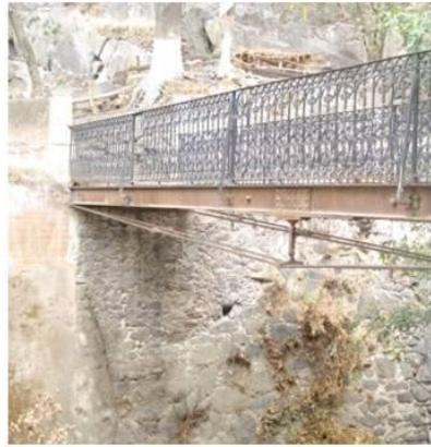
G21. PUENTE DE METAL.
