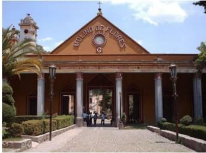
G 12. PÓRTICO DE ACCESO
