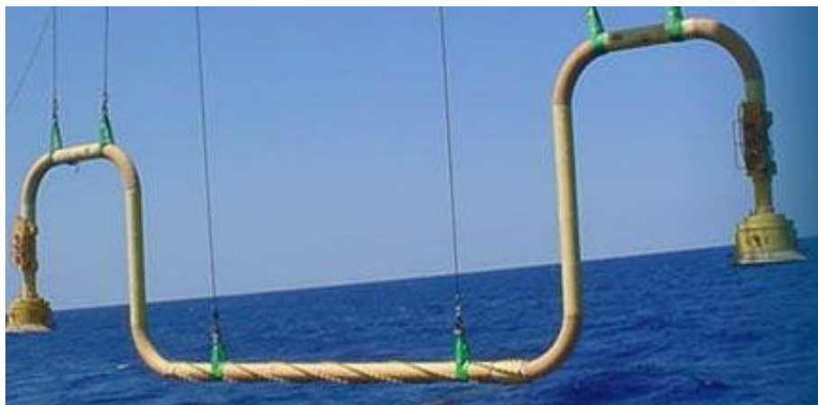
Figura 1.17 Operación de conexión de Jumper
