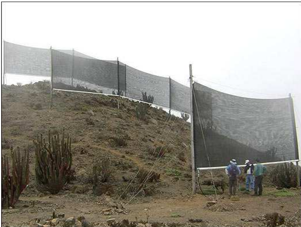
Fig. 5 Captadores de niebla en Chile Falda Verde
