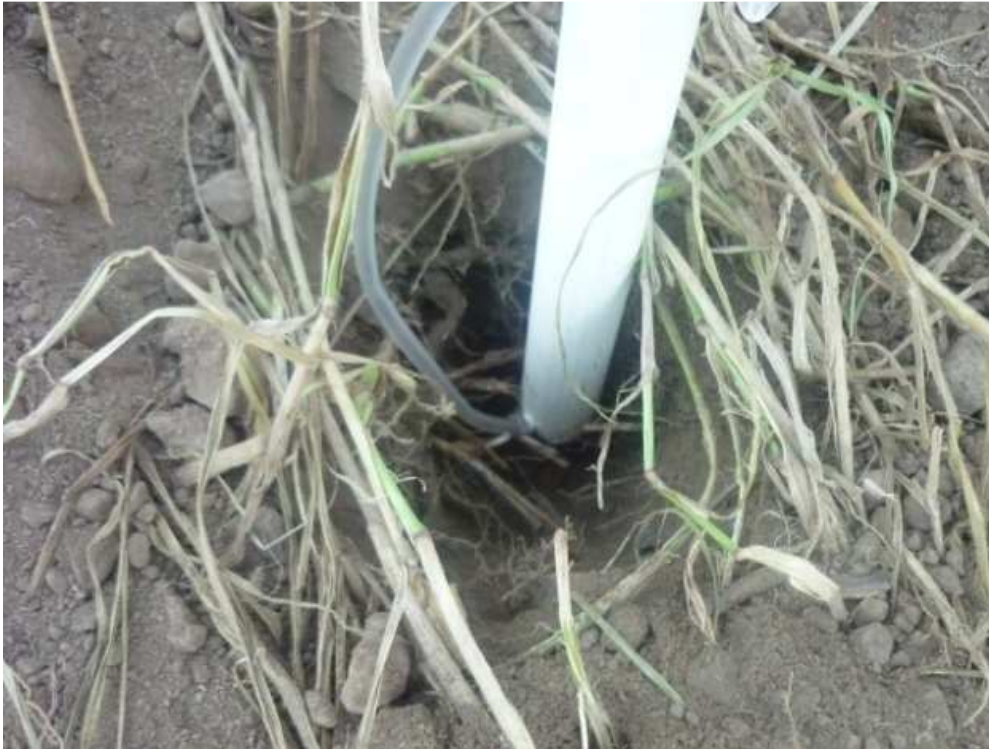
Fig. 35 Colocación del SCARN-MEX en la excavación
