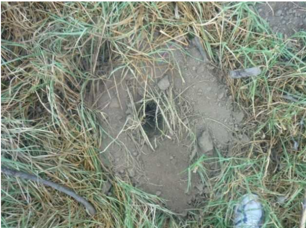
Fig. 34 Excavación para la colocación del SCARN-MEX
