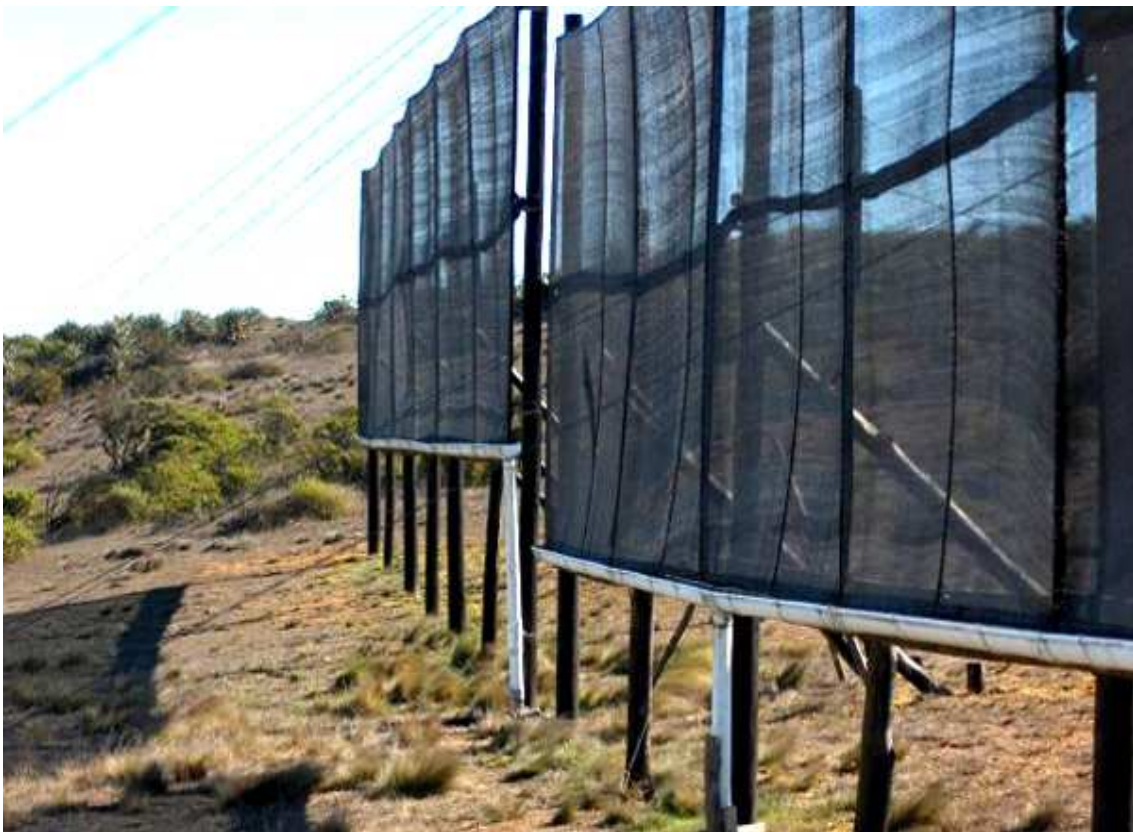
Fig. 15 Atrapanieblas con un sistema de recolección y distribución de PVC
