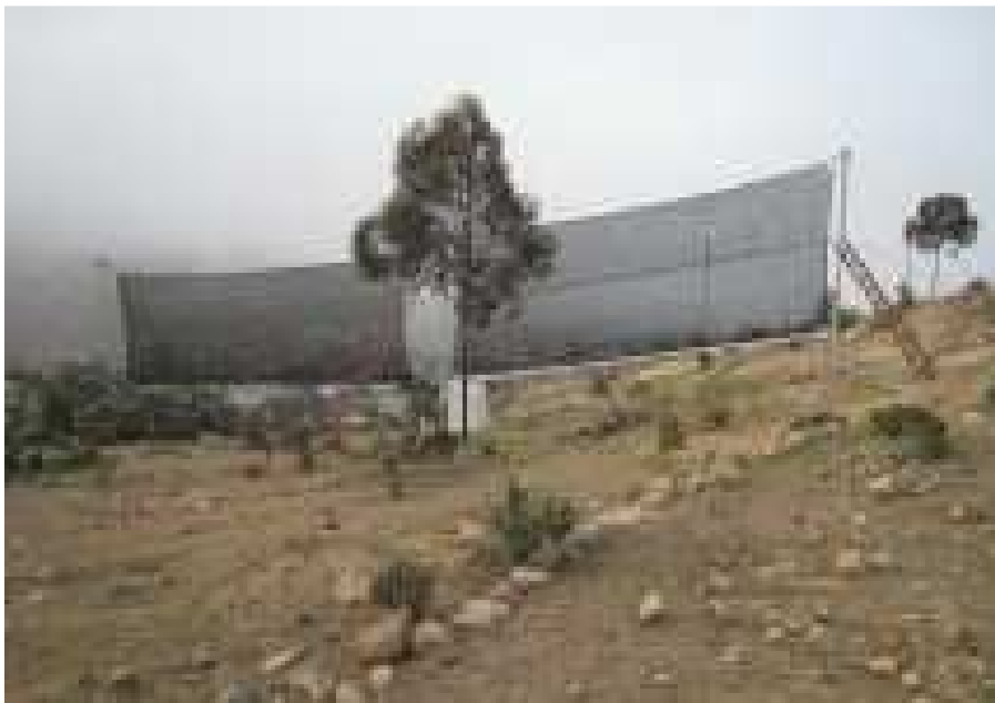
Fig. 8 El primer colector dual en Nefasit está listo para funcionar
