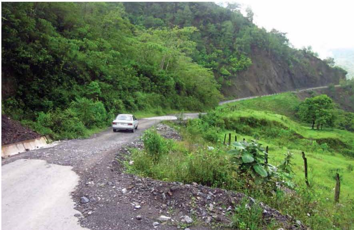
Figura. 2.13. Deslizamiento rotacional en la carretera de Pahuatlán a Xochimilco.
