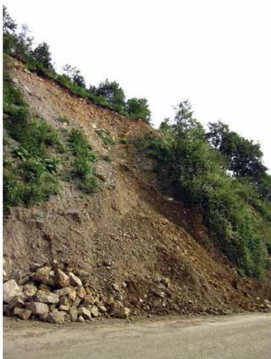
Figuras 2.18 y 2.19. Izquierda, deslizamiento translacional en el poblado de Paciotla. Derecha, deslizamiento de suelo en el valle del río San Marcos.
