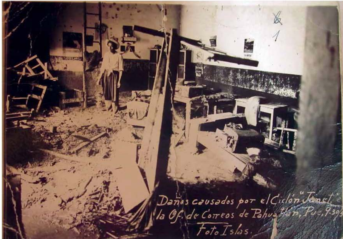
Figura. 2.12. La oficina de correos en la calle Dos de Abril, la mancha negra en la pared indica el nivel alcanzado por el lodo. (Fuente: Archivo de Raúl López).
