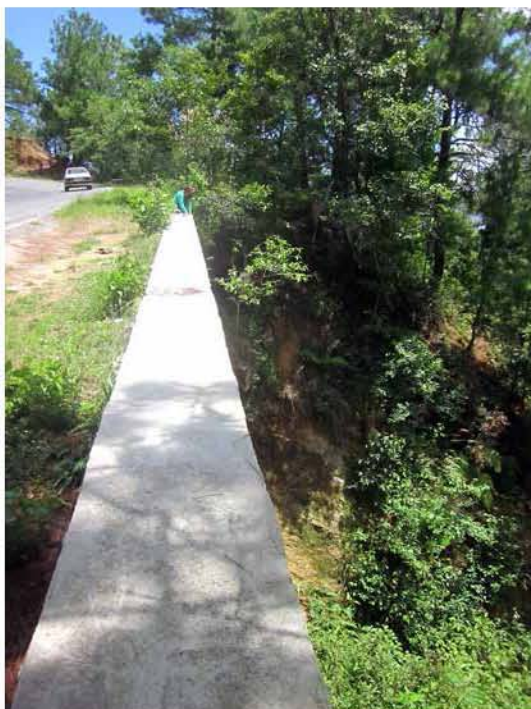
Figuras 2.15 y 2.16. Izquierda, muro de contención construido luego de un deslizamiento sobre la carretera de Honey-Pahuatlán. A la derecha, caída de material en la carretera de Pahuatlán a San Pablito.
