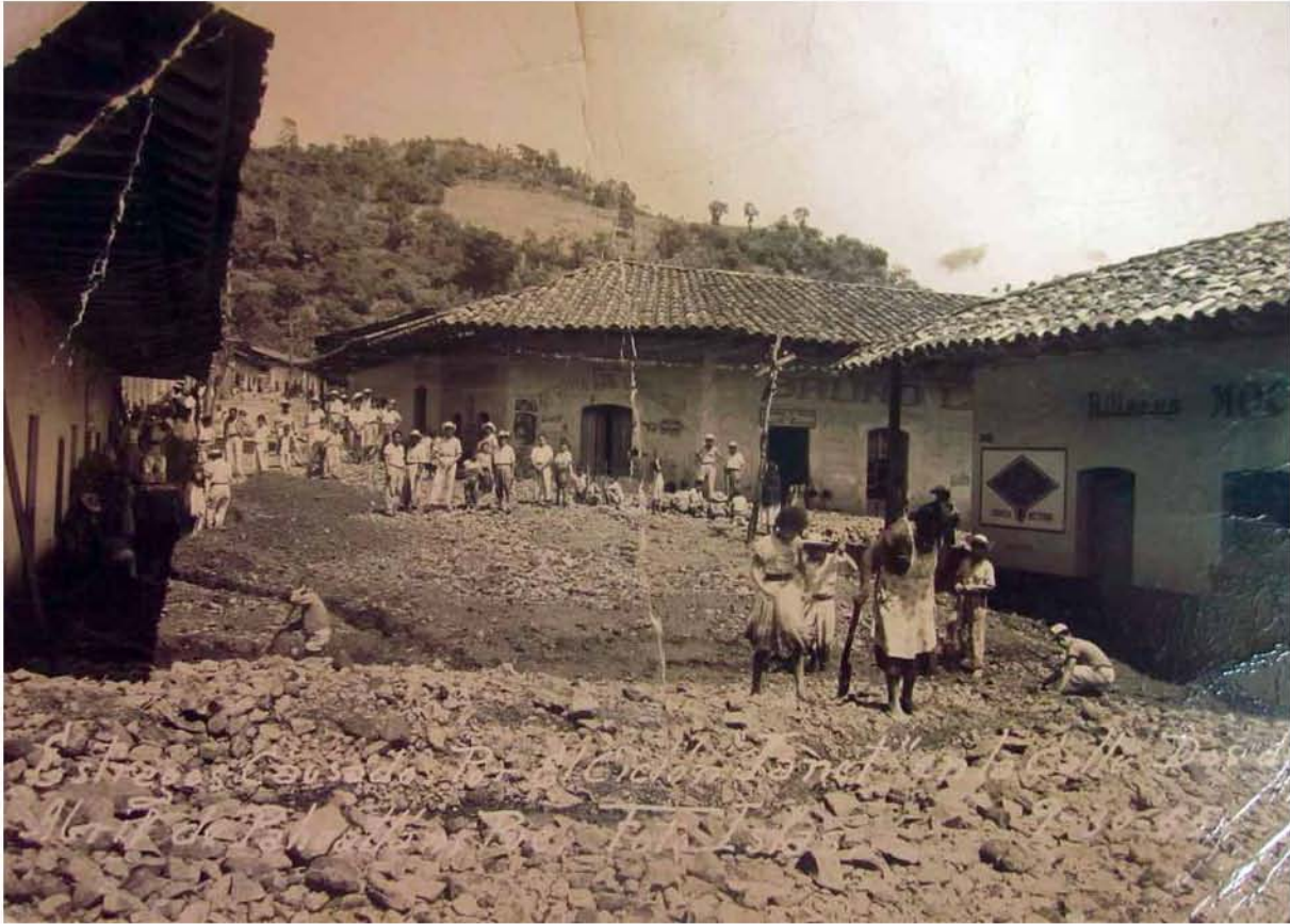
Figura. 2.11. Labores de limpieza en la calle Dos de Abril, se observa el tipo de material que bajó por la ladera e ingresó a las casas. (Fuente: Archivo de Raúl López).
