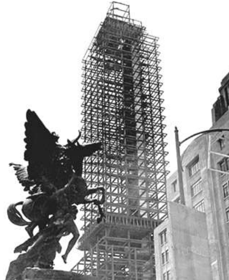
Figura 2.4. Estructura de la Torre Latinoamericana.
