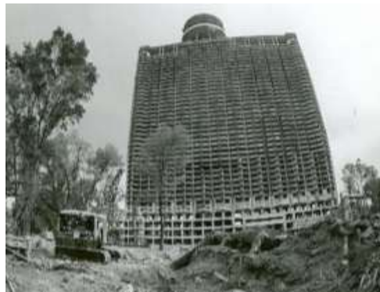
Figura 2.5. Estructura concluida del actual WTC de la Ciudad de México.
