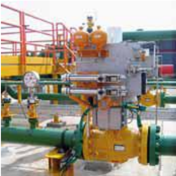
Fig. 2.10 HIPS con dos iniciadores mecánicos. Cortesía de Mokveld
