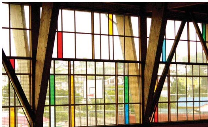
Ventanales en fachada Foto: © Jorge Lobos
