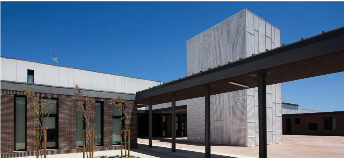
Acceso Principal y andadores. Foto: © João Morgado
