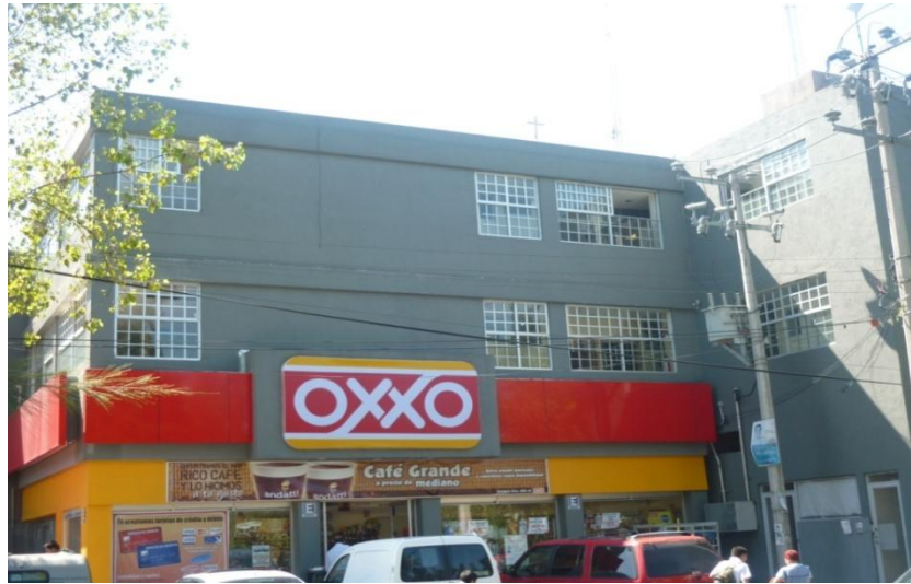
Imagen 11. Ubicación de las oficinas que ocupaba la agencia aduanal
