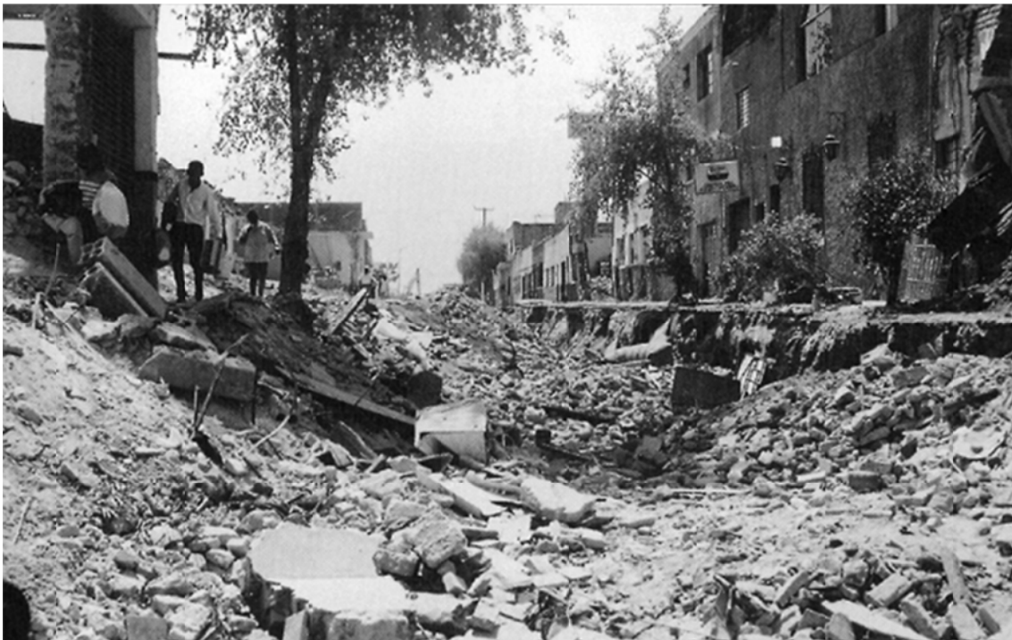
Fig. 8 Explosión en el alcantarillado de Guadalajara
