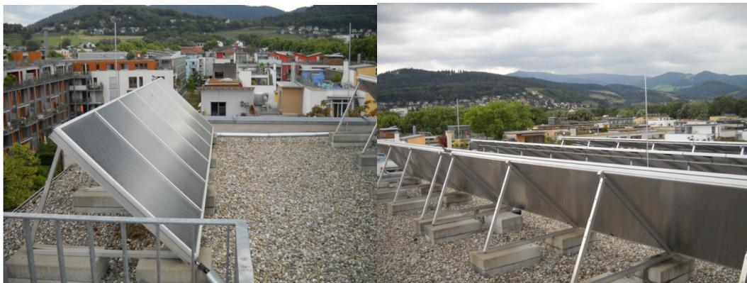
**Figura 2.28 Conjuntos habitacionales del proyecto Vauban en Freiburg, Alemania con sistemas híbridos de calentamiento solar y paneles fotovoltaicos interconectados a la red eléctrica.**
