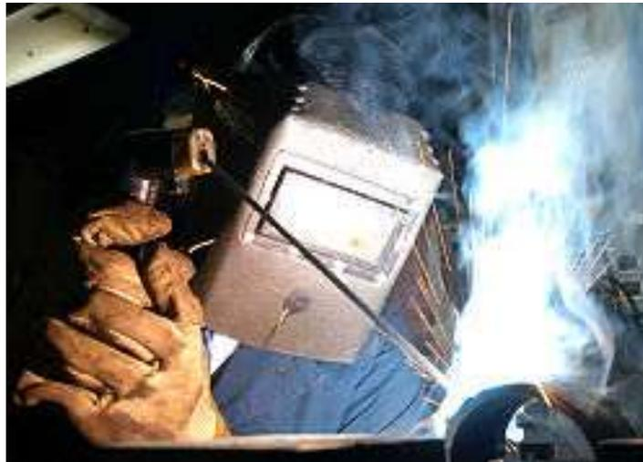
Figura 1.1 Soldadura con electrodo revestido
