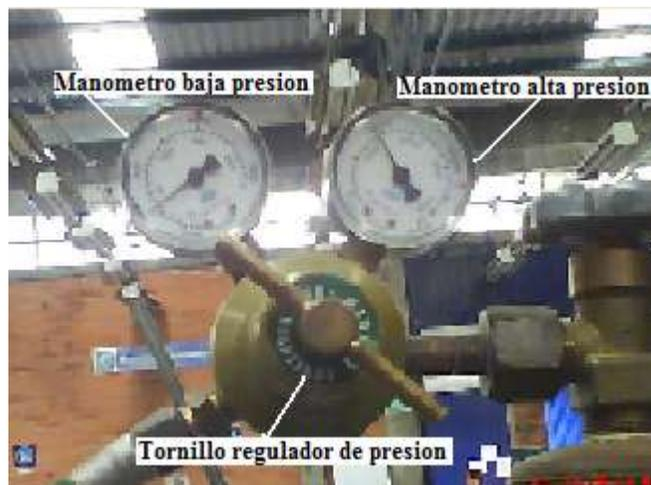
Figura 5.13 Manómetros del tanque de oxígeno
