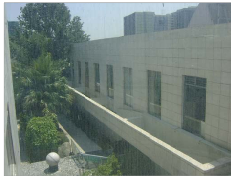
EDIFICIO DE GOBIERNO
