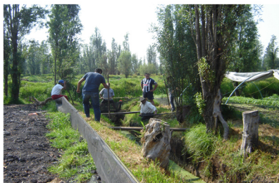
Limpieza de canal.
