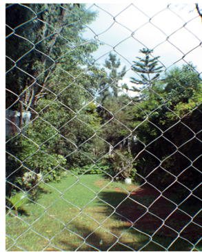
Canal tapado. Obra de restauración del gobierno.
