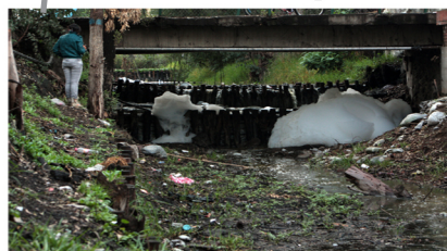
Tratamiento de agua.
