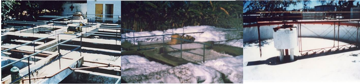
Figura 14. Fotografías de la Planta de tratamiento
