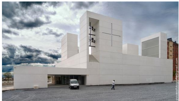
FACHADA PRINCIPAL (ESTE)
