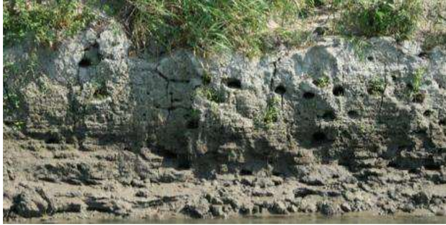
Fig. 1-20 Evidencias de tubificación en márgenes del río Carrizal.
