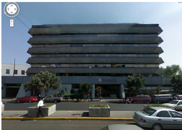
Figura 2.1 Edificio en el que se localiza la Contraloría Interna en la Secretaría de Obras y Servicios (De Google Maps)
