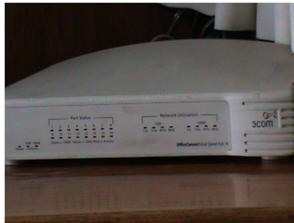
Figura 2.8 Switch 3Com en la Subdirección “B”.
