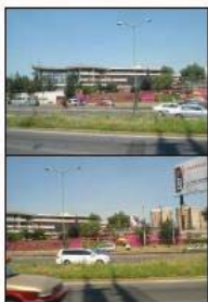
V-6 EDIFICIO EDUCATIVO COLINDANTE AL PONIENTE
