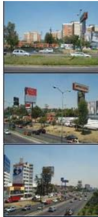
V-10 EDIFICIO HABITACIONAL COLINDANTE AL ORIENTE
