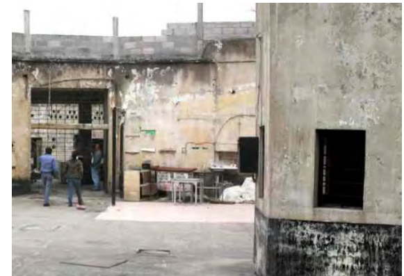
Vista interior de la torre panóptica
