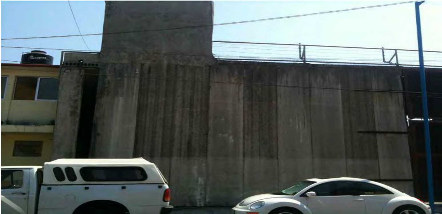
Muro de seguridad perimetral del Ex- Penal
