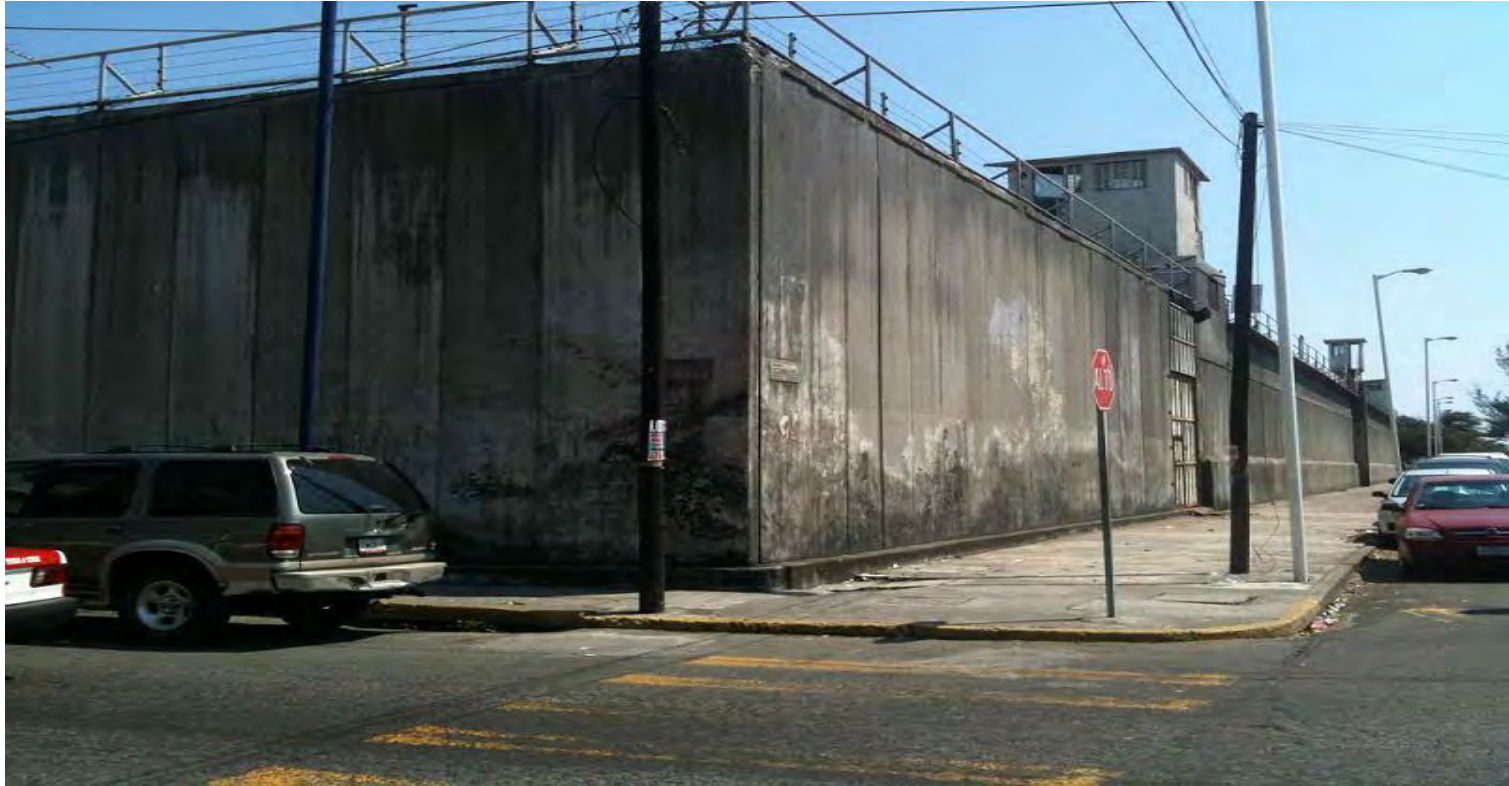
Muro de seguridad perimetral del Ex- Penal
