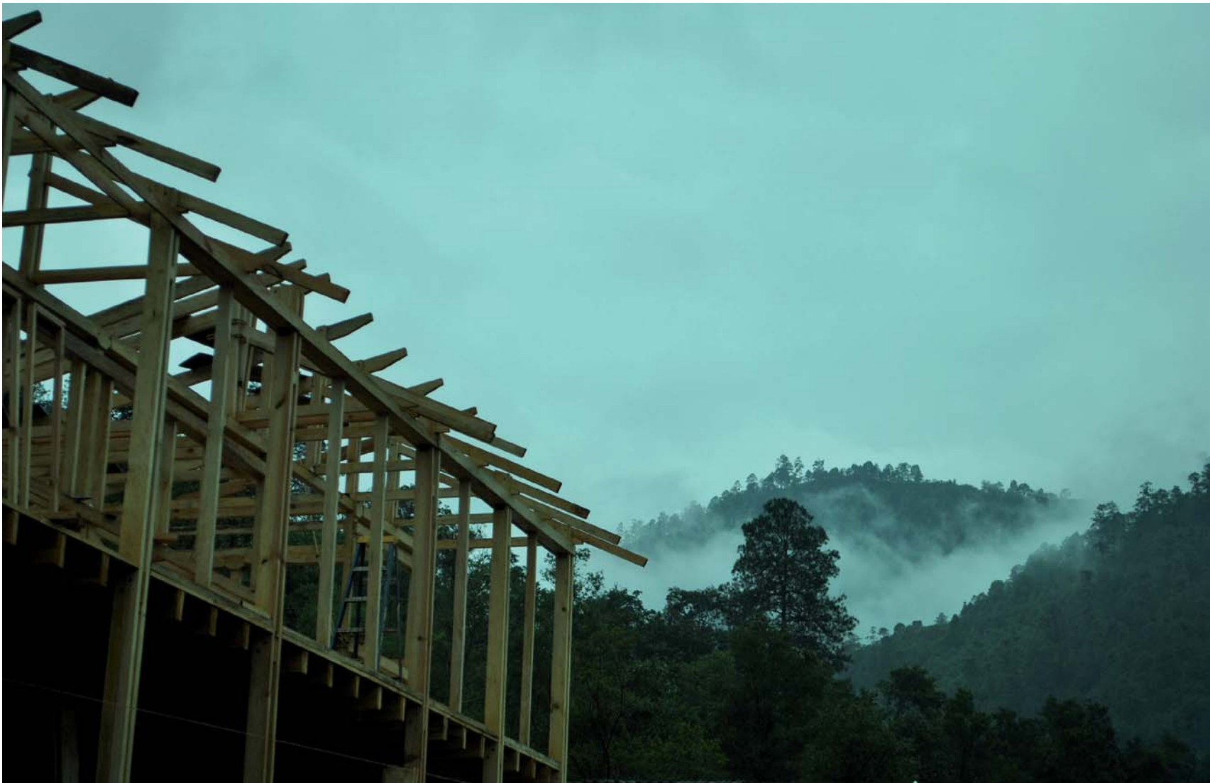
CMTS construido con madera de la región.
