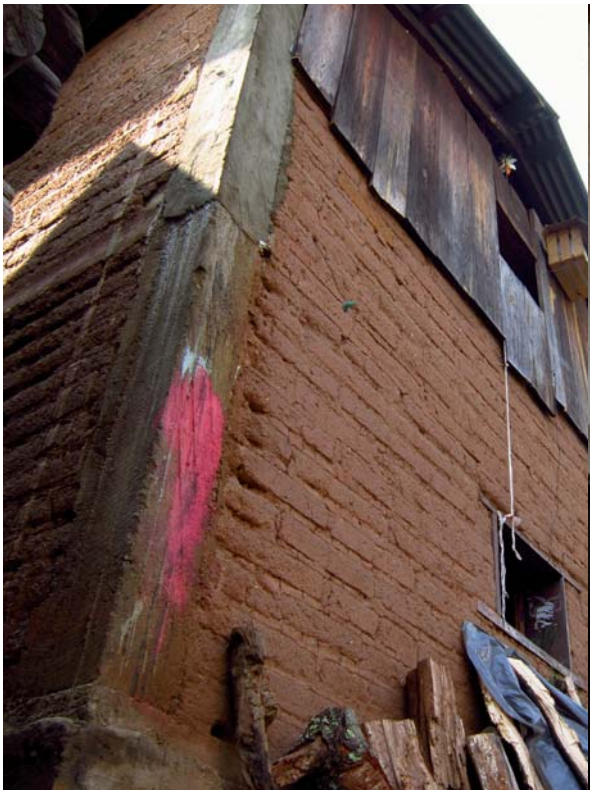
Castillos de concreto con adobe
