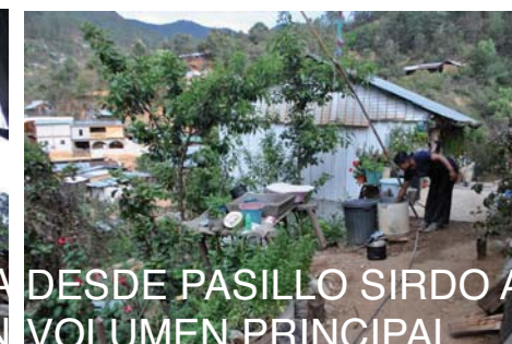
COCINA EN CONSTRUCCIÓN
