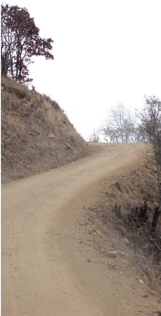
Carretera PLM-San Miguel Peras
