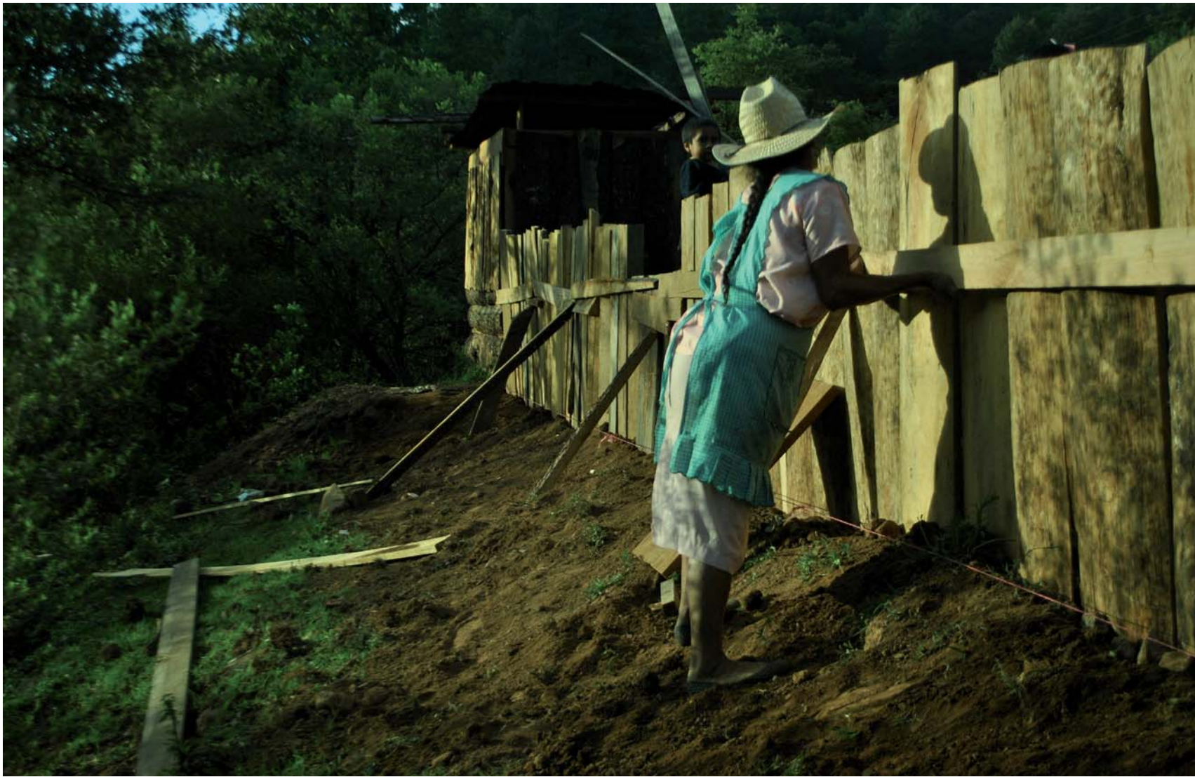
Lucila construyendo el muro de contención del patio del proyecto
