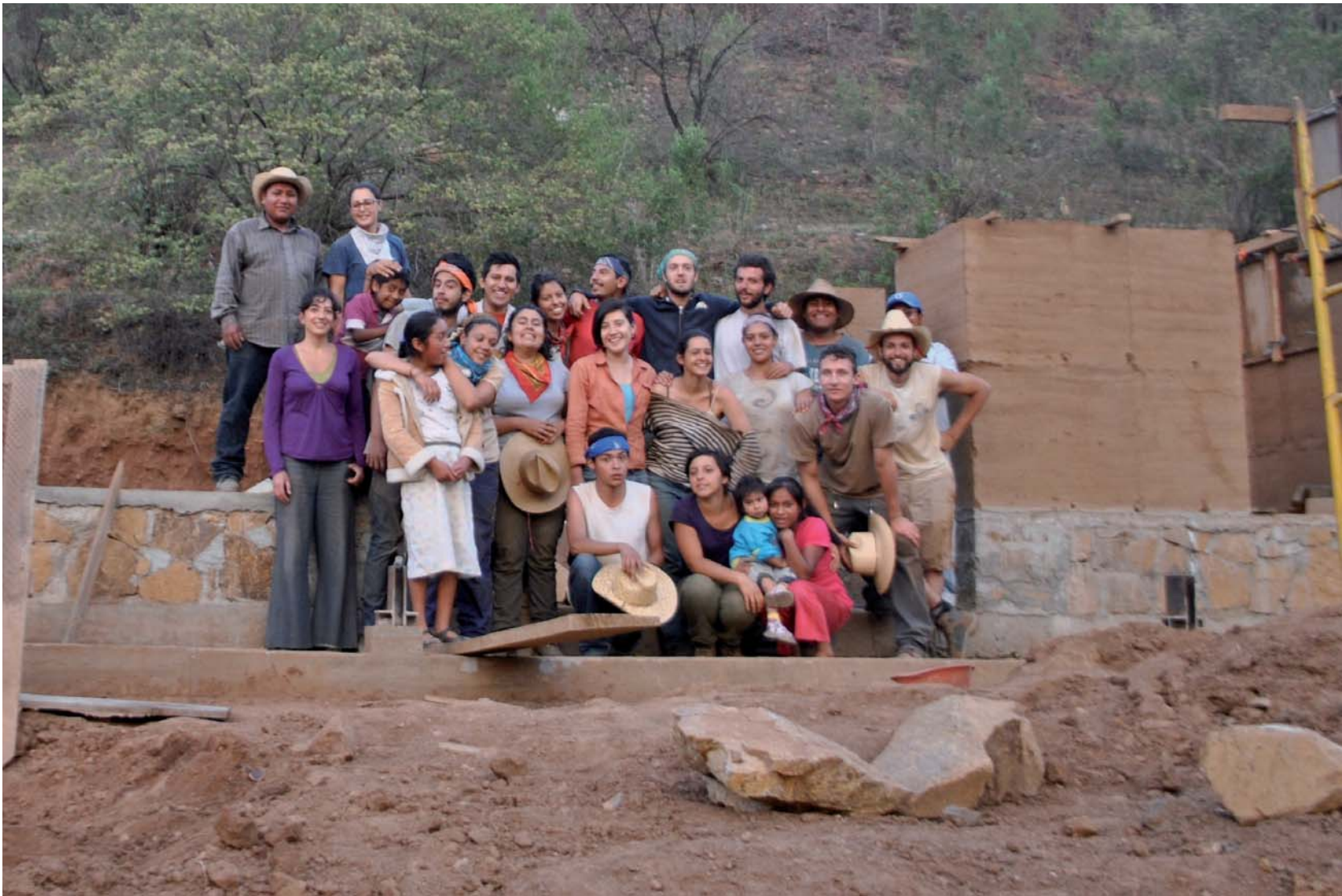
Después de mes y medio, un módulo de tierra construido.
