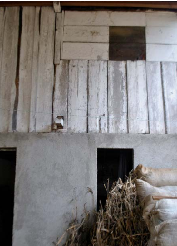
Concreto con madera
