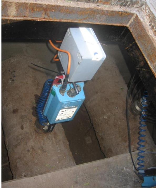
**Figura 3.6 Medición de caudal con medidor electromagnético de inserción**
