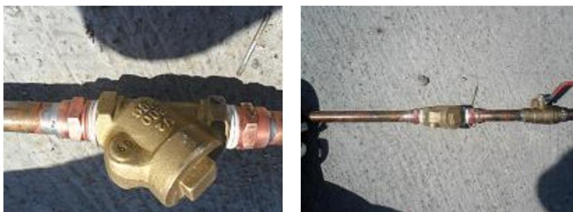
Fig. 4.64 Valvula check en la conexión para alimentación de agua.
