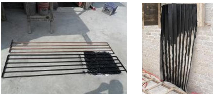
Fig. 4.22 Pintado de la lamina y el radiador.
