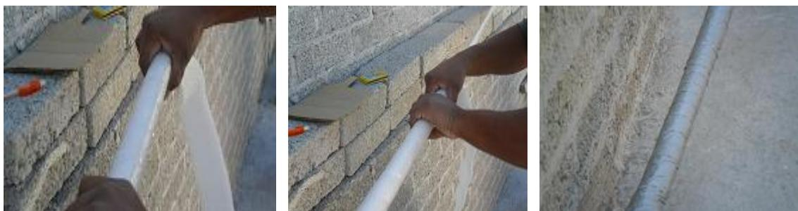
Fig. 4.57 Recubrimiento del tubo.
