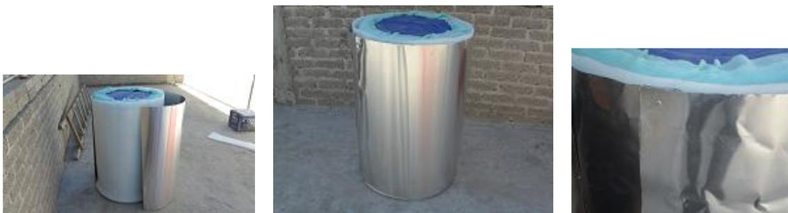
Fig. 4.46 Recubrimiento de aluminio.
