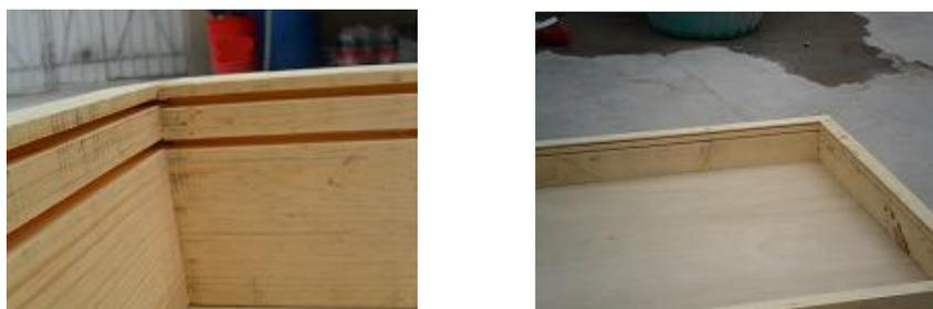
Fig. 4.25 Ranuras para el paso de los vidrios.
