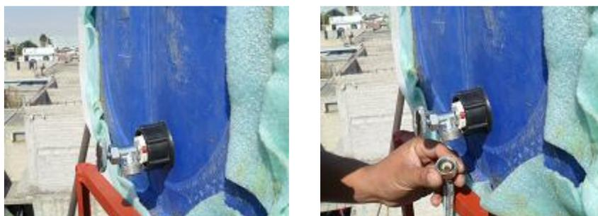
Fig. 4.51 Brida para entrada de agua del calentador hacia el tambo colector.
