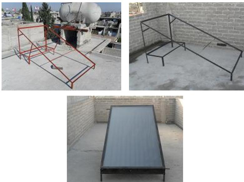
Fig. 4.40 Angulo y posición de la estructura.
