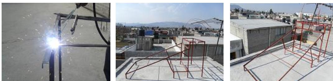
Fig. 4.41 Colocación del soporte del depósito de agua.
