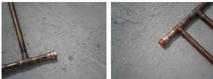
Fig. 4.16 Soldado de las conexiones macho y hembra.
