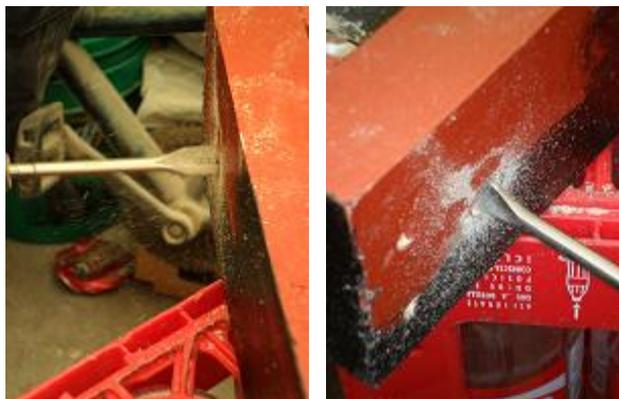
Fig. 4.31 perforación del colector.
