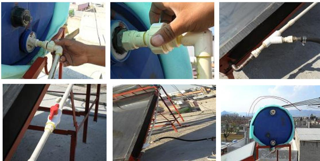
Fig. 4.58 Conectando los tubos.
