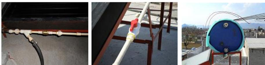
Fig. 4.56 Tubo de regreso y válvula check.
