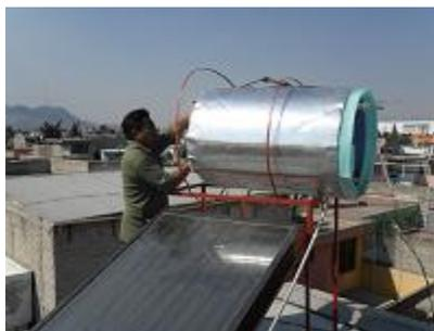
Fig. 4.53 Colocación del tanque en la estructura.
