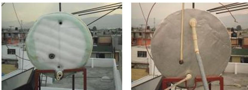
Fig. 4.65 Aislado y sellado del contenedor de agua.
