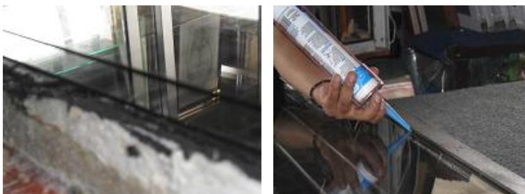
Fig. 4.36 sellado de silicón.
