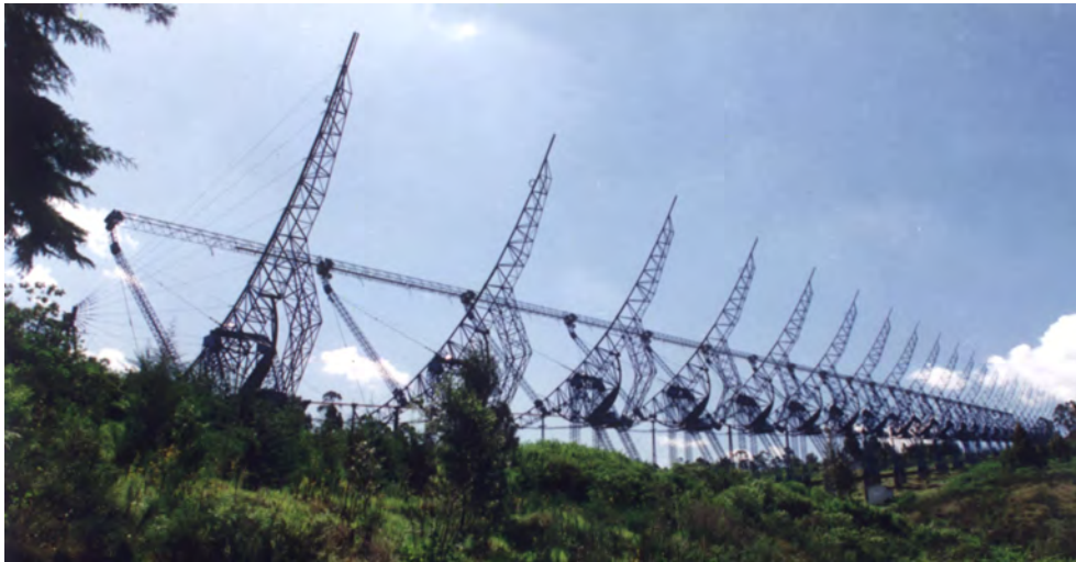
Figura 3.9: El radiotelescopio de Ooty fue construido en una colina con una pendiente natural de 11 grados, igual a la latitud geográfica de Ooty. Tiene una cobertura de 530 m Norte-Sur \times 30 m Este-Oeste. Imagen tomada de http://rac.ncra.tifr.res.in/OotyRadioTelescope.html .
