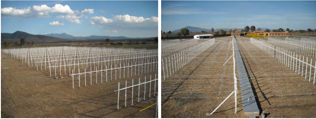
Figura 3.2: Las fotografías muestran dos perspectivas de la antena del MEXART. A la izquierda: foto tomada desde la parte sureste del arreglo. Se aprecian los postes blancos que sostienen las líneas de dipolos que componen la antena. A la derecha: Parte central de la antena tomada desde la zona sur hacia el norte. En el centro, al nivel del suelo, se muestra un conducto que termina en la parte norte, el cual, lleva las señales de las líneas de la antena hacia la torre de control en el fondo. Los dipolos están orientados perpendicularmente al conducto. En el conducto subterráneo se lleva a cabo la suma de ramas y la segunda etapa de filtraje y amplificación.
