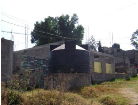
14/febrero/2011 Valle de las Luces, Iztapalpa, DF. Mamila antigua sin mangueras
