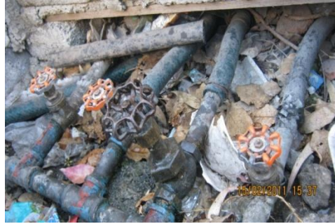
15/febrero/2011 San Nicolás II, Tlalpan, DF. Conexiones caseras al ramal
