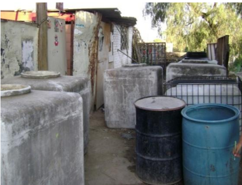
14/febrero/2011 Valle de las Luces, Iztapalpa, DF. Tinacos de asbesto
