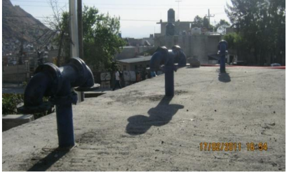
17/febrero/2011 Tlalpexco, GAM, DF. Techo de la Bomba de la colonia
