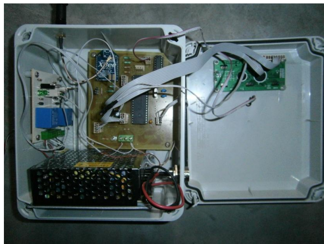
Figura 6.33.- Acoplamiento final del módulo de humedad.
