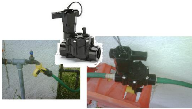
6.41.- Instalación de la electroválvula para automatizar riego.
