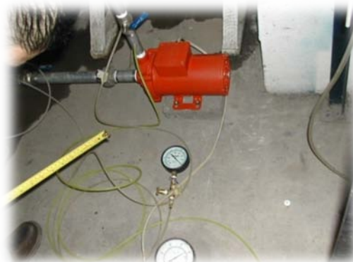
Figura 62.- Manómetro y Vacuómetro de Bourdon
