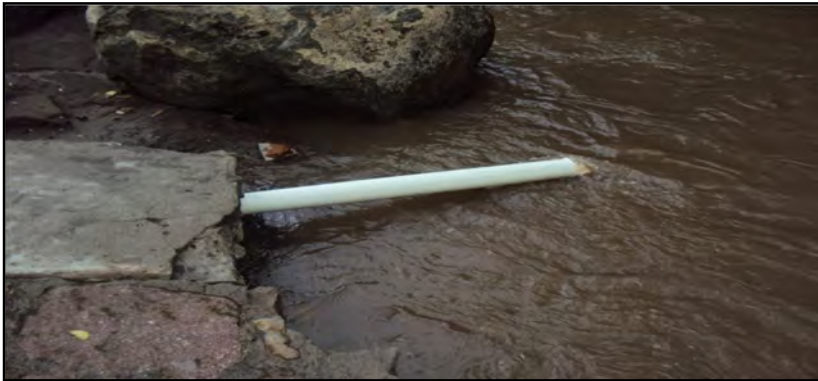
IMAGEN 5.18 DRENAJE CON SALIDA AL RIO CHALMA
