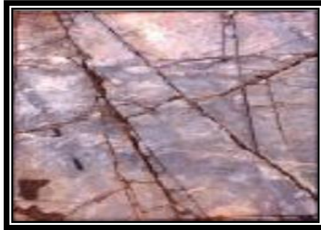
Figura 3.3 Bloque de roca fracturada
