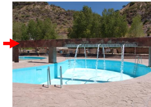
Figura 16. La flecha indica el acueducto aéreo por donde viaja el agua para abastecer las diferentes piscinas del balneario.
