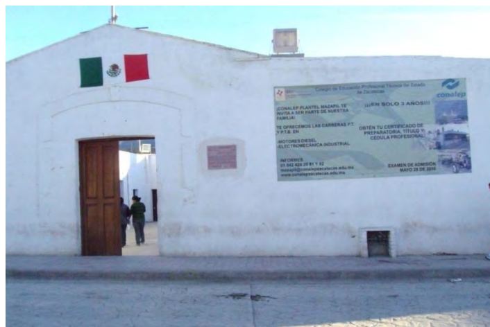
Figura 31. Vista exterior del albergue.
