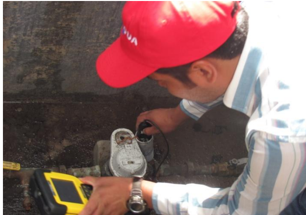
Figura 24. Trabajos en campo. Lectura del consumo de agua en los medidores de agua instalados en las dependencias universitarias.
