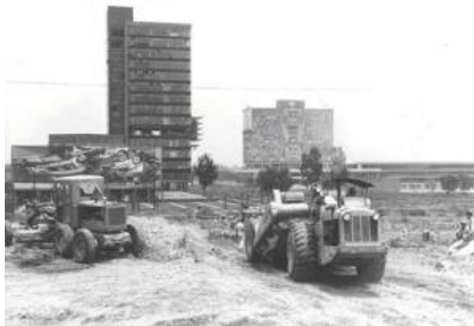
Figura 16. Construcción de Ciudad Universitaria en el año 1952, UNAM.
