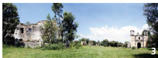
Se aprecia parte de la fachada suroeste del Casco y la fachada de acceso a la capilla.
