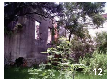
Vista interior del Casco, hacia el suroeste.
