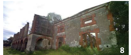
Vista desde la esquina norte del Casco.
