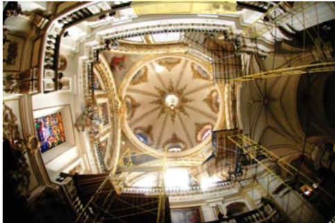
Restauración de la cúpula de la Catedral Metropolitana.
