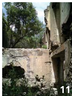
Vista interior del Casco, hacia el noreste.
