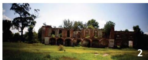
Fachada sureste, acceso al Casco.
