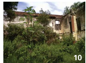
Vista interior del Casco, hacia el noroeste.
