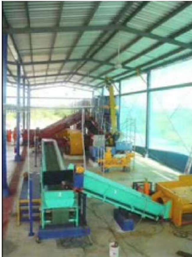
Figura 16. Vista de la planta de fabricación
