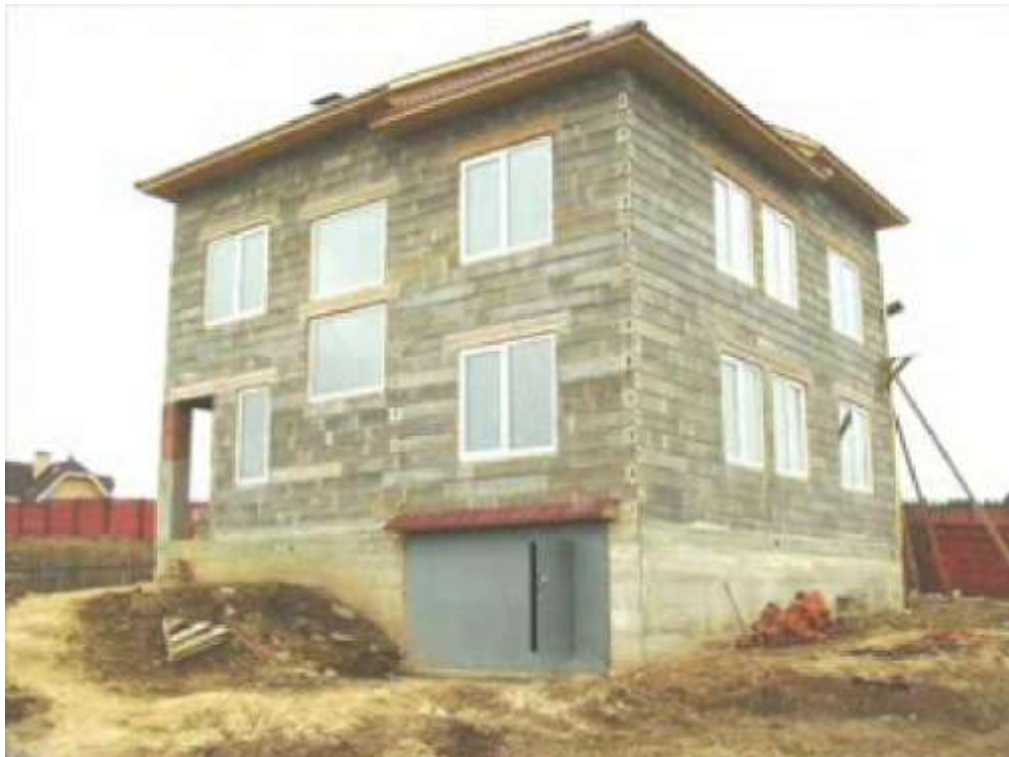
Figura 25. Aplicación en edificación
