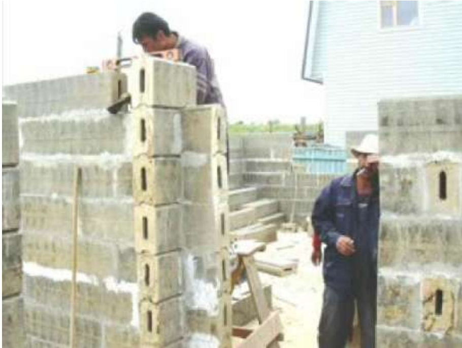
Figura 24 .Aplicación en construcción
