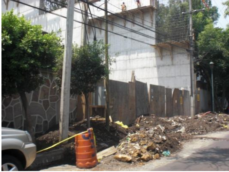
Postes de luz y teléfono
