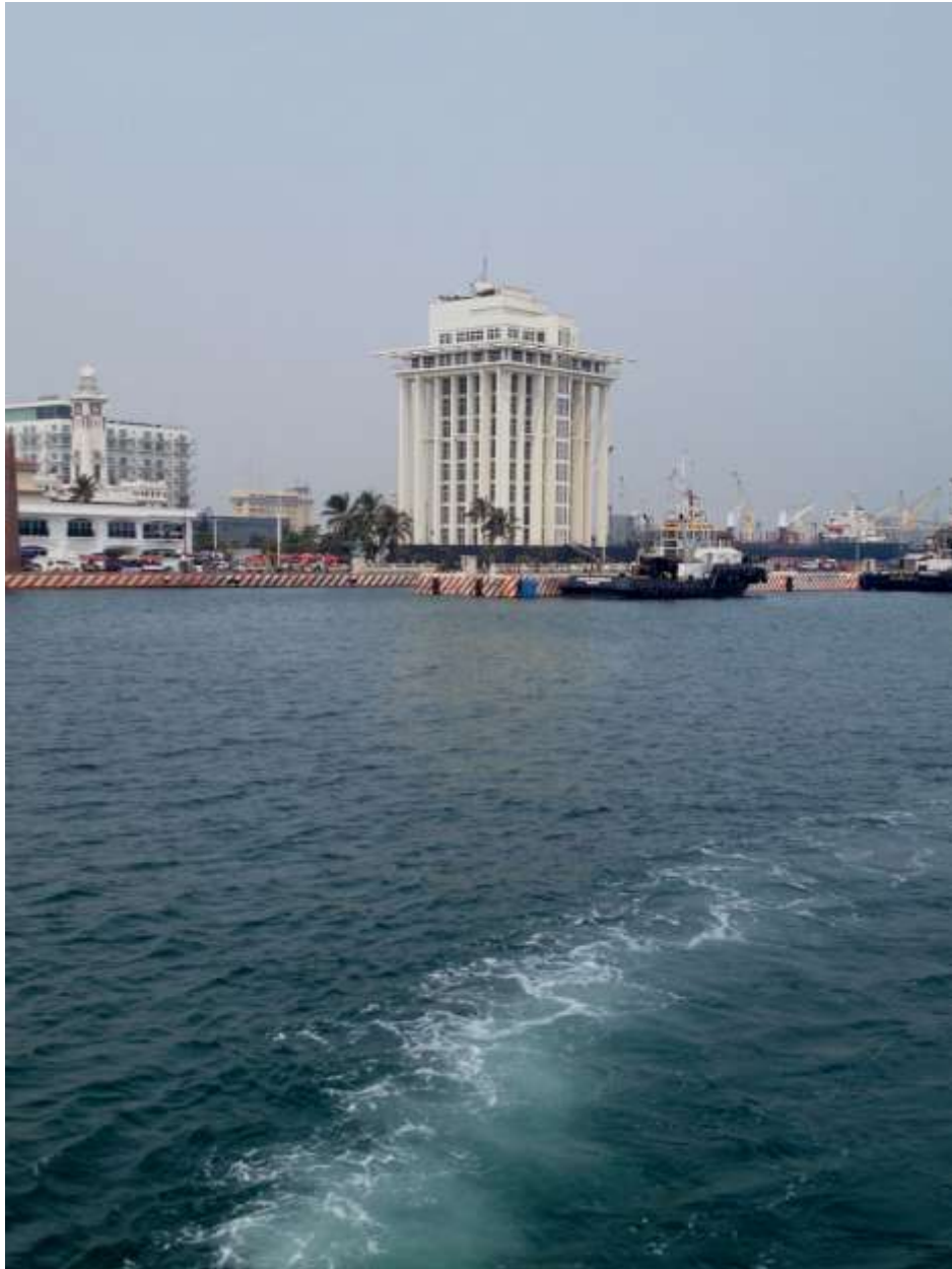
Muelle utilizado para el arribo ocasional de cruceros de pasajeros en el Puerto de Veracruz (imagen propia, 2013)
