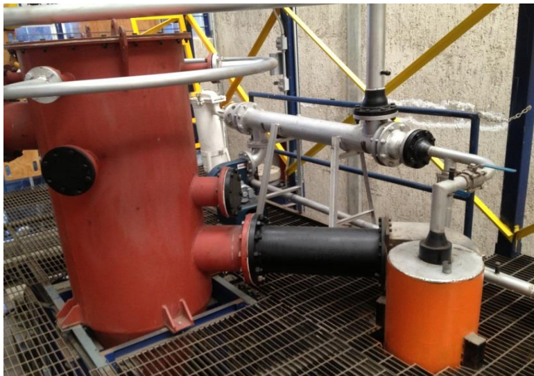
Figura 20. Vista del gasificador y el ciclón.
