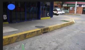
Conclusiones: drenaje insuficiente en area de puestos de comida, lo que ocasiona malos olores y suciedad. Falta de mantenimiento en coladeras
